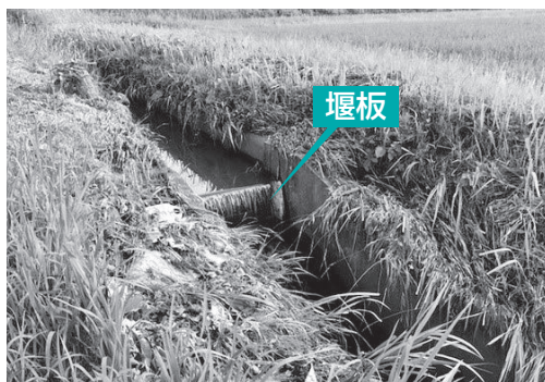
▲堰板が設置してある排水路
